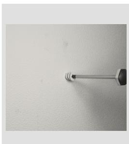
②ねじ込んだビスを取り外してビス穴に合わせてアンカー (小) を水平にしながらプラスドライバーで【ゆっくり】締めていきます。壁と面一になるまで締めます。
