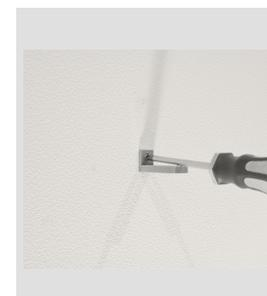
④ホルダーを取り付けていきます。締めすぎるとアンカーが回りしてしまうのでご注意ください。ホルダーにガタが無い程度で大丈夫です。
