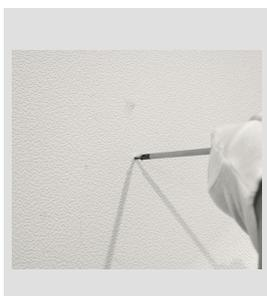
①まず最初に付属の下穴用ビス (6mm) で取り付ける物を壁に合わせて位置を決めてねじ込んでいきます。最後まで締めて空回りした場合はそのまま引き抜き②へ移行します。梁に当たってしまった場合はアンカーは使用せずにそのままビスでホルダーを固定します。
