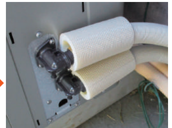
機器への継手接続/ 継手保温材を被せて施工完了
